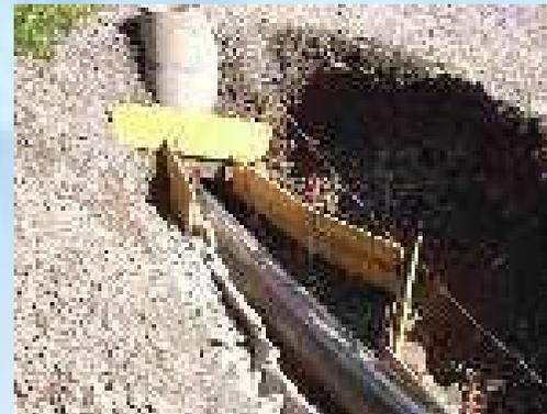
Cette technique consiste à mettre en place dans une canalisation à réhabiliter une nouvelle conduite de diamètre inférieur.
