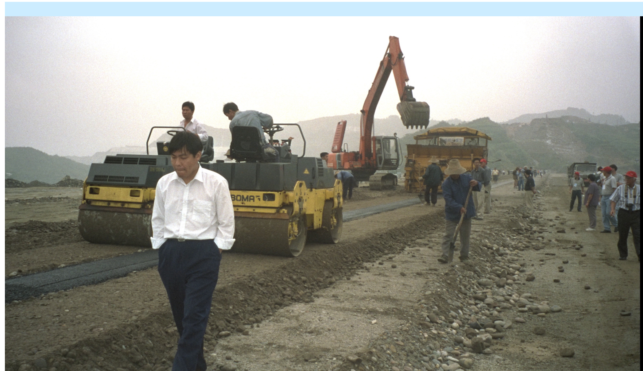
Saddle Dam, Trois Gorges, Chine
