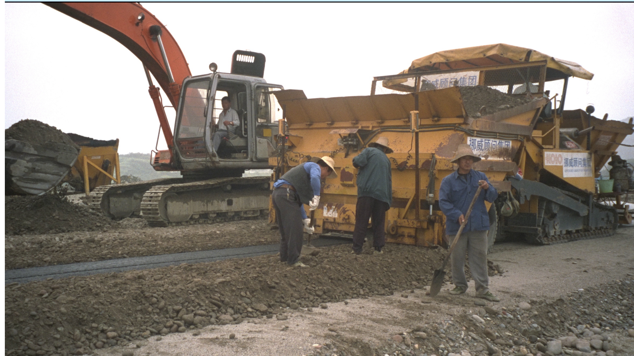
Saddle Dam, Trois Gorges, Chine
