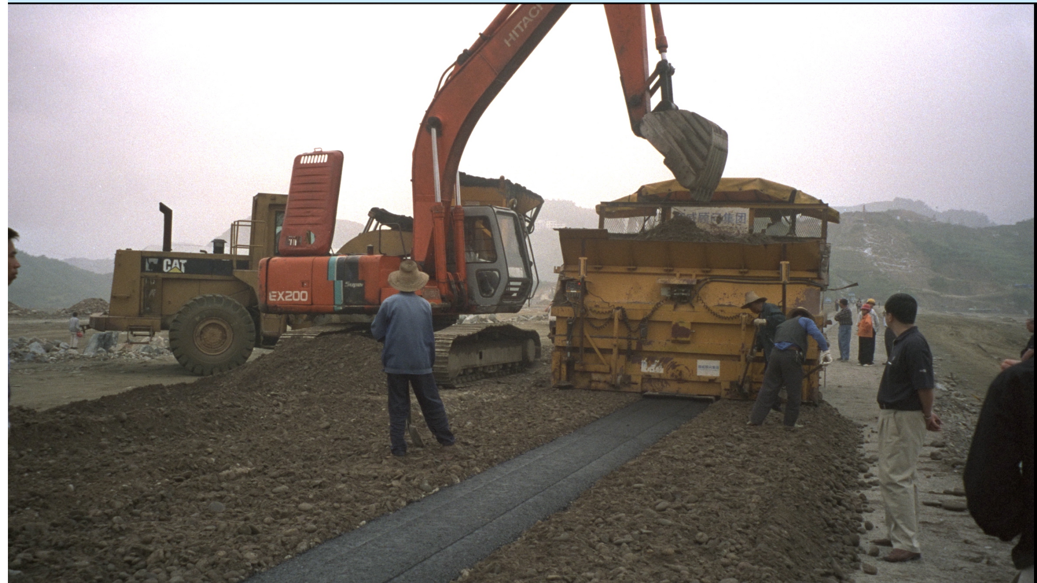
Saddle Dam, Trois Gorges, Chine
