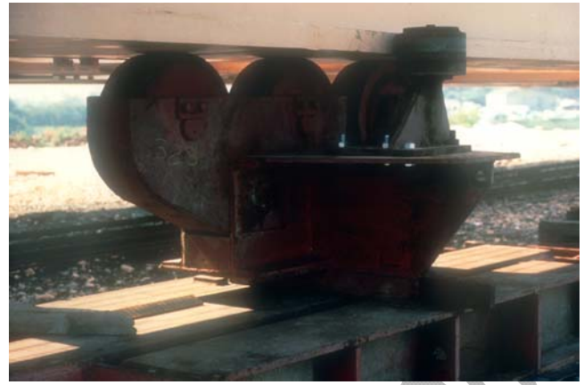
Appui roulant
