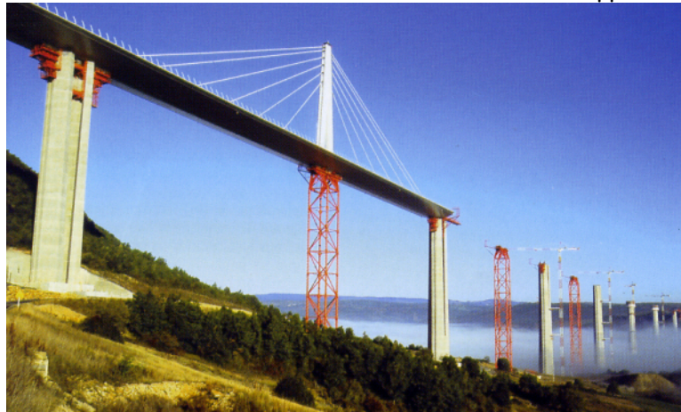
Pont de Millau : haubanage et palées provisoires
