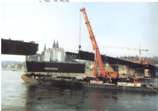
g) Ponts sur cours d'eau. Tronçon de tablier amené par barge et hissage.
