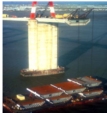
g) Ponts sur cours d'eau. Tronçon de tablier amené par barge et hissage.
