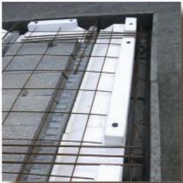
Plancher Hourdis Béton Rupteur Total : Stoptherm ES+EP
