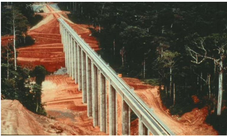
Viaduct en Cameroon utilisation de ciment avec fumée de silice importé du Canada - pour amélioration d'étanchéité
