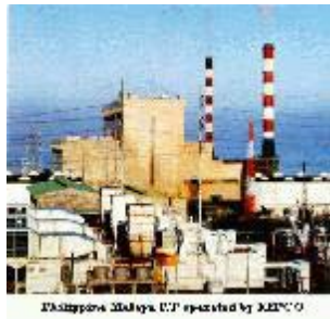
Centrale d'électricité thermique
