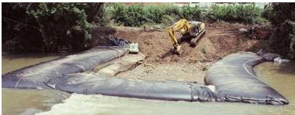
FIGURE 4.4.6 STRUCTURES TUBULAIRES REMPLIES D'EAU : FLEXIBILITÉ, ANGLES, COUPLAGE DES TUBES (« AQUA-BARRIER »)
