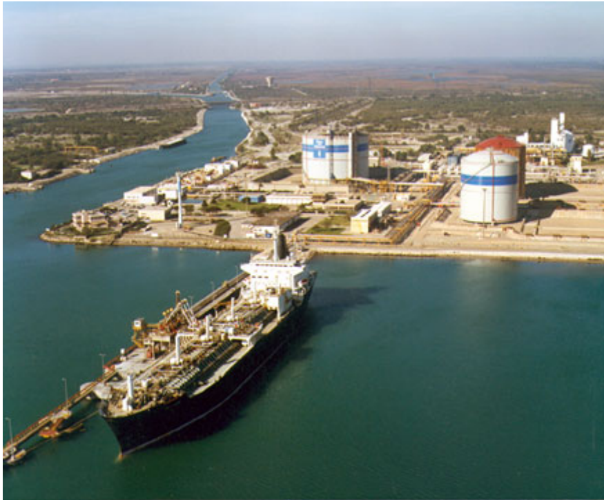
Poste pour réception du gaz liquéfié à Marseille-Fos (photo Port autonome de Marseille J.P JAUFFRET)
