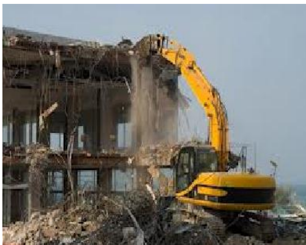
Fig 24: Démolition par pelle hydraulique
