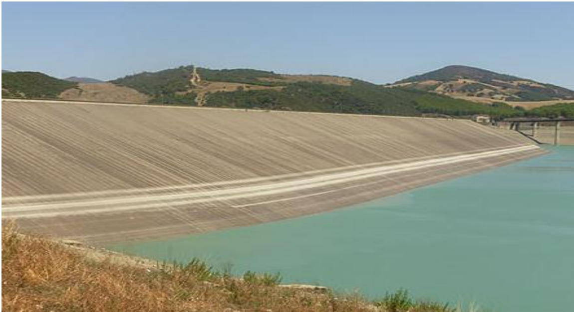
Fig 16: Exemple digue en terre
