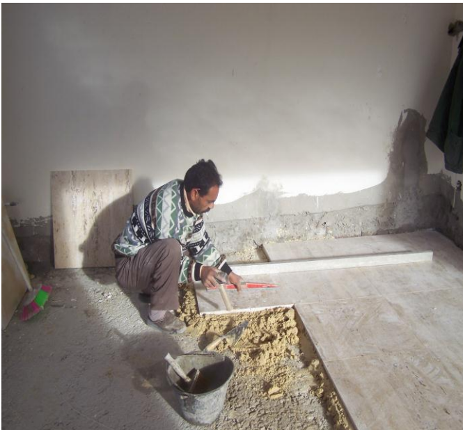
Fig 6 : Revêtement au sol (carrelage)
