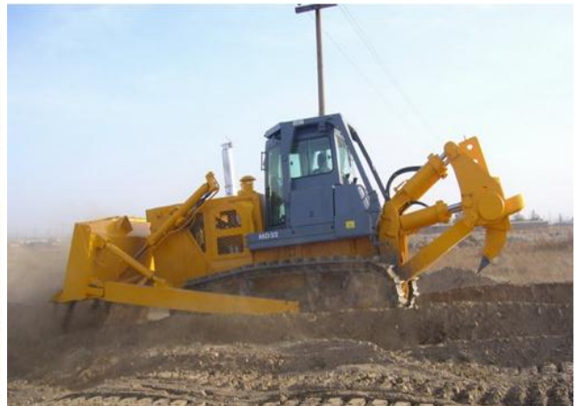
Fig 27: Décapage avec « Bulldozer »
