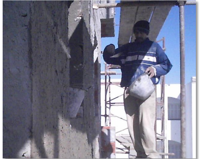
Fig 5 : Enduit extérieur
