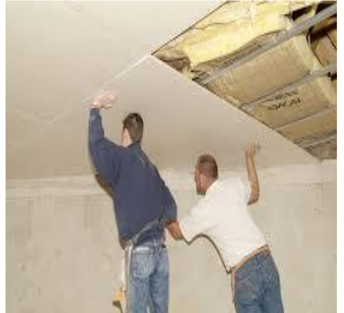
Fig 7 : Plâtre (faux plafond)
