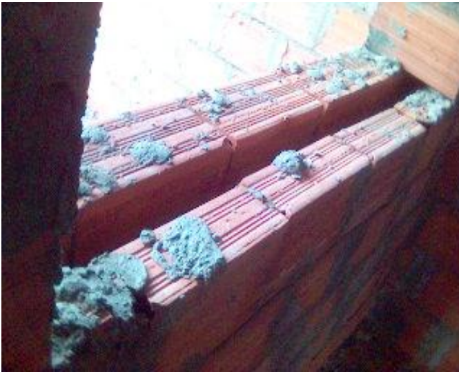
Fig 4 : Maçonnerie et cloisonnement
