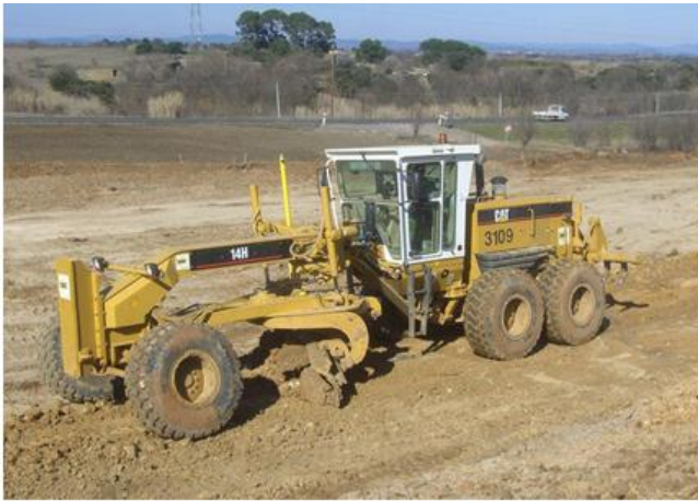
Fig 26: Décapage avec « Niveleuse »
