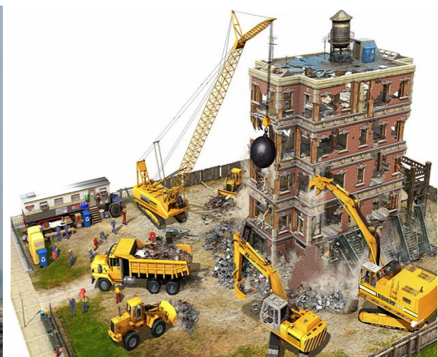
Fig 25: Démolition par Boulet ou « drop ball »
