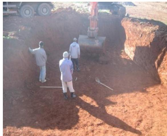
Figure 4.6 : Fouilles en pleine masse ou en excavation
