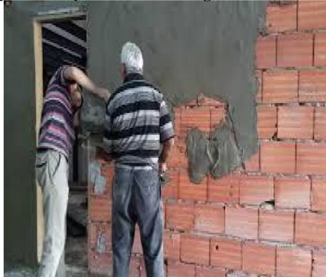
**Figure 5.4 :** Enduit au ciment sur murs
