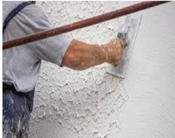
**Figure 5.3 :** Enduit au plâtre sur murs
