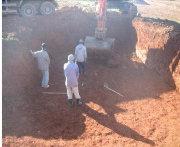
**Figure 4.3** : Déblai d'un terrain
