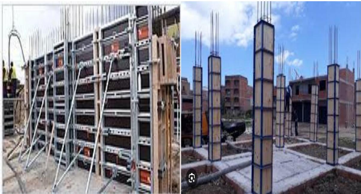
**Figure 6.2 :** Coffrage métallique
