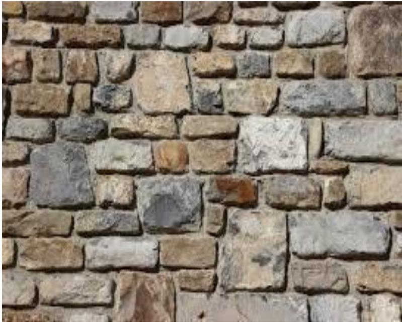
**Figure 5.1** : Maçonnerie de moellons
