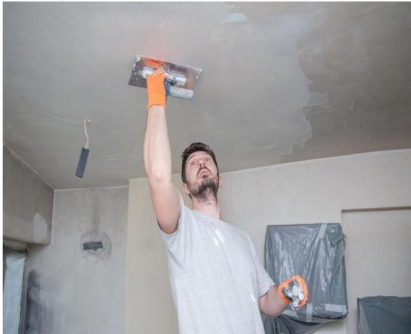
**Figure 5.2 :** Enduit au plâtre sous plafonds
