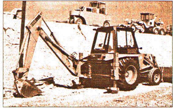
Fig. 3.4. : Emprise du terrassement
