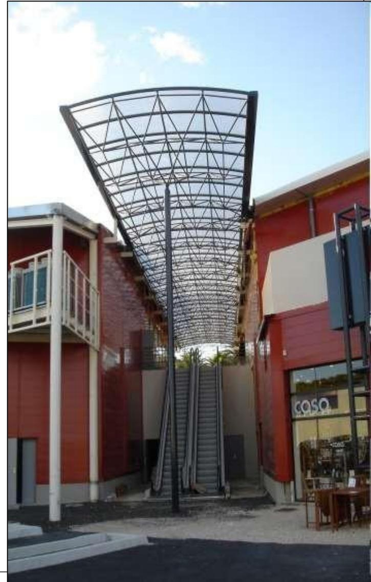
*- Elle se compose d'un réseau de pannes dans le sens longitudinal, et de pannes ceintrées dans le sens transversal.*
