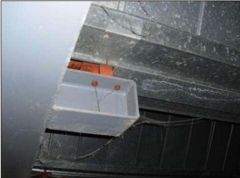
**Assemblage boulonné de la poutre de la toiture avec la poutre principale.**
