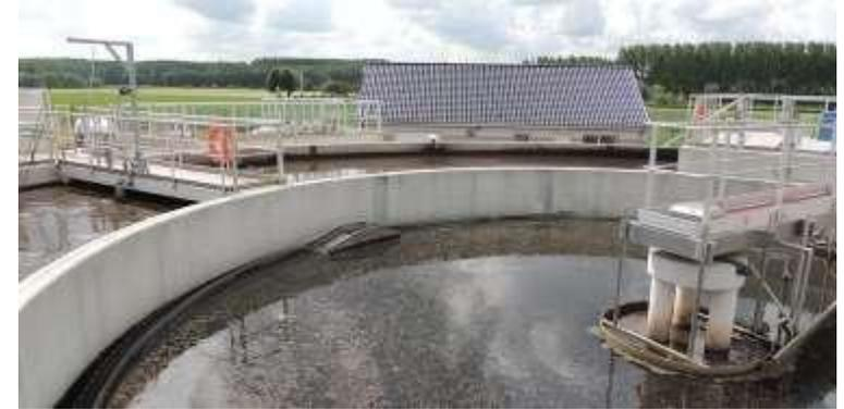
Les bassins sont équipés d'un pont automoteur et de pompes aératrices. Ces pompes, installées le long de chaque ouvrage, diffusent de fines bulles d'air qui favorisent la remontée des graisses et corps flottants en surface.
