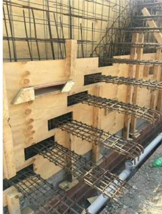
**Figure :** Exemple d'escaliers en porte à faux transversalement
