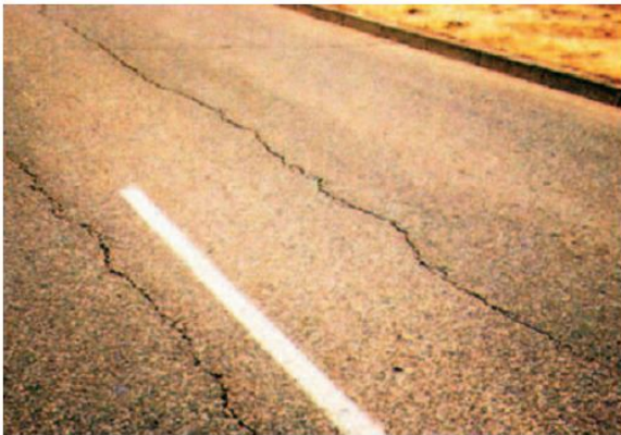
FIGURE 4. Fissuration longitudinale
