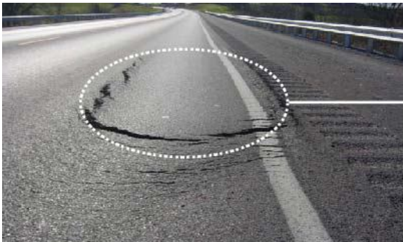
FIGURE 6. Dégradation due à un défaut de collage à l'interface (Buchanan et Woods, 2004)
