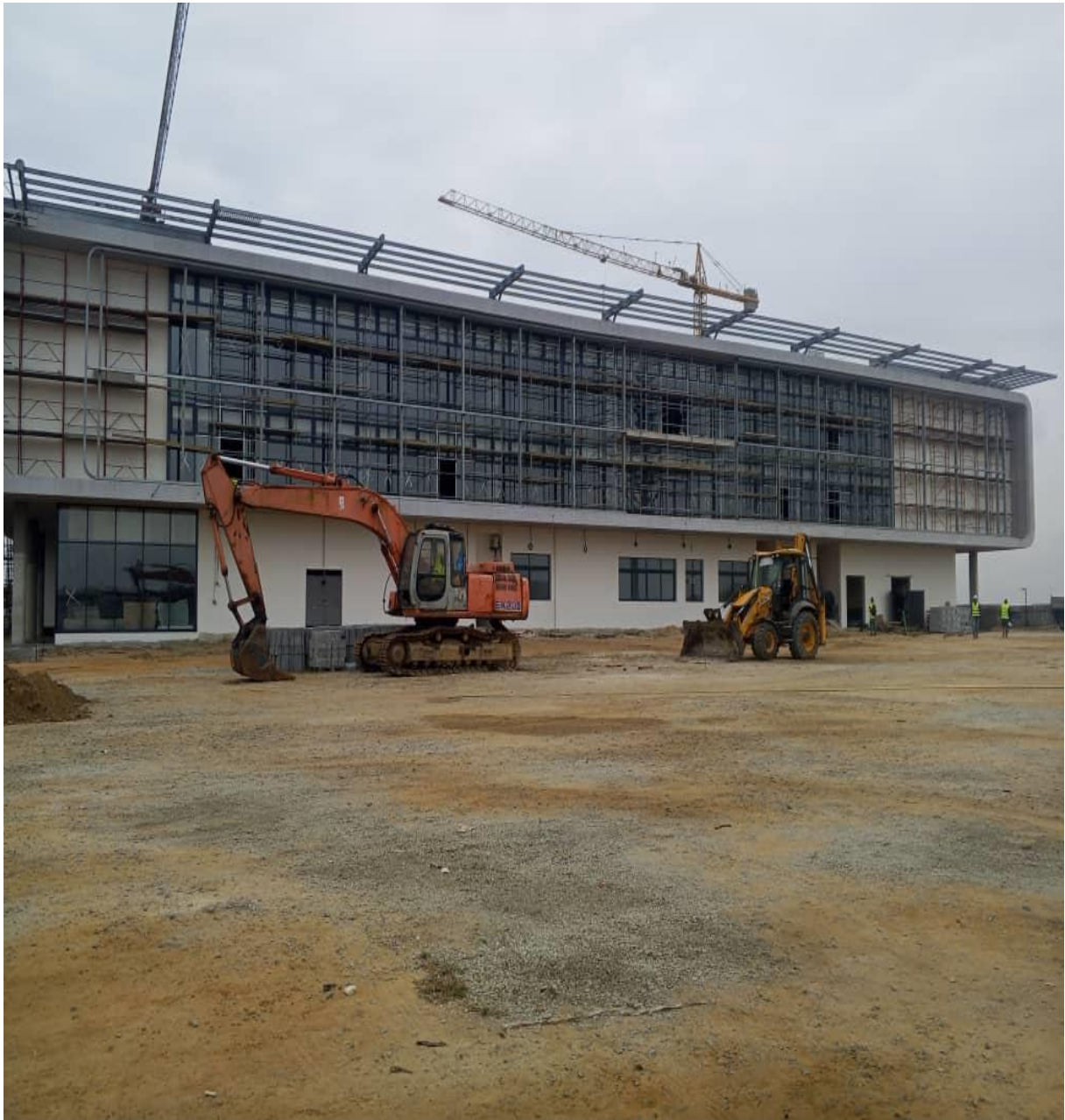
Vue de face du Bâtiment en finition
