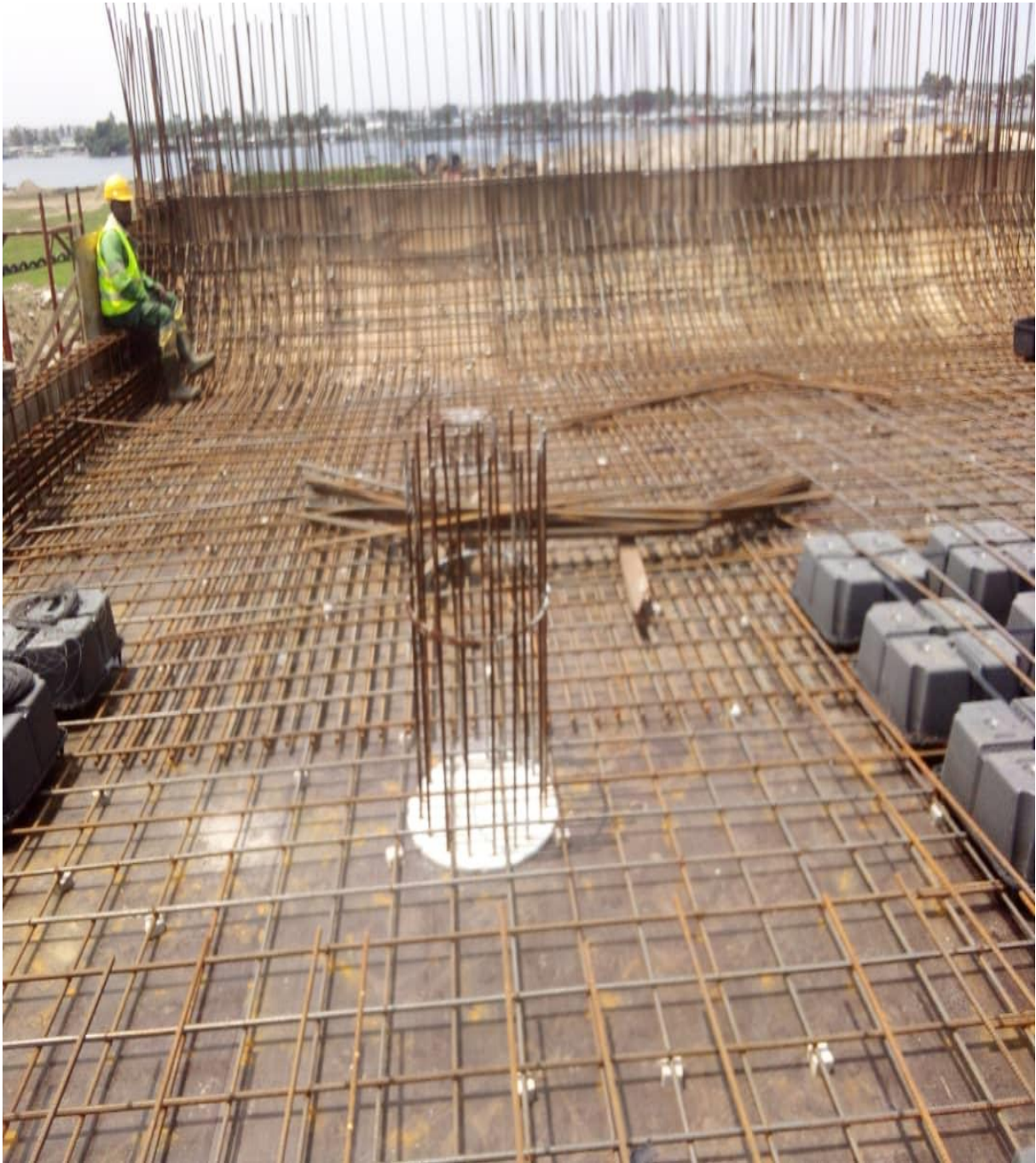
Début De Ferrailage Du Plancher
