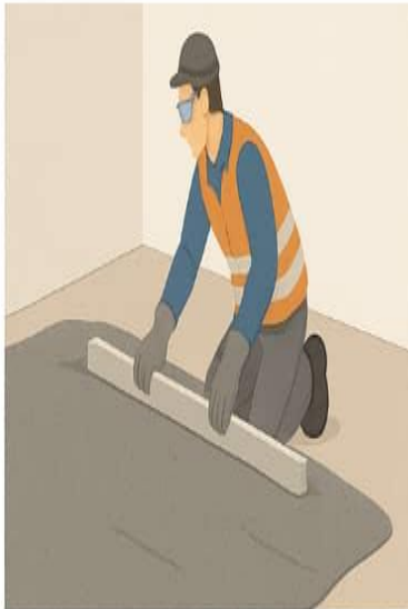
5. Lissage de la surface
