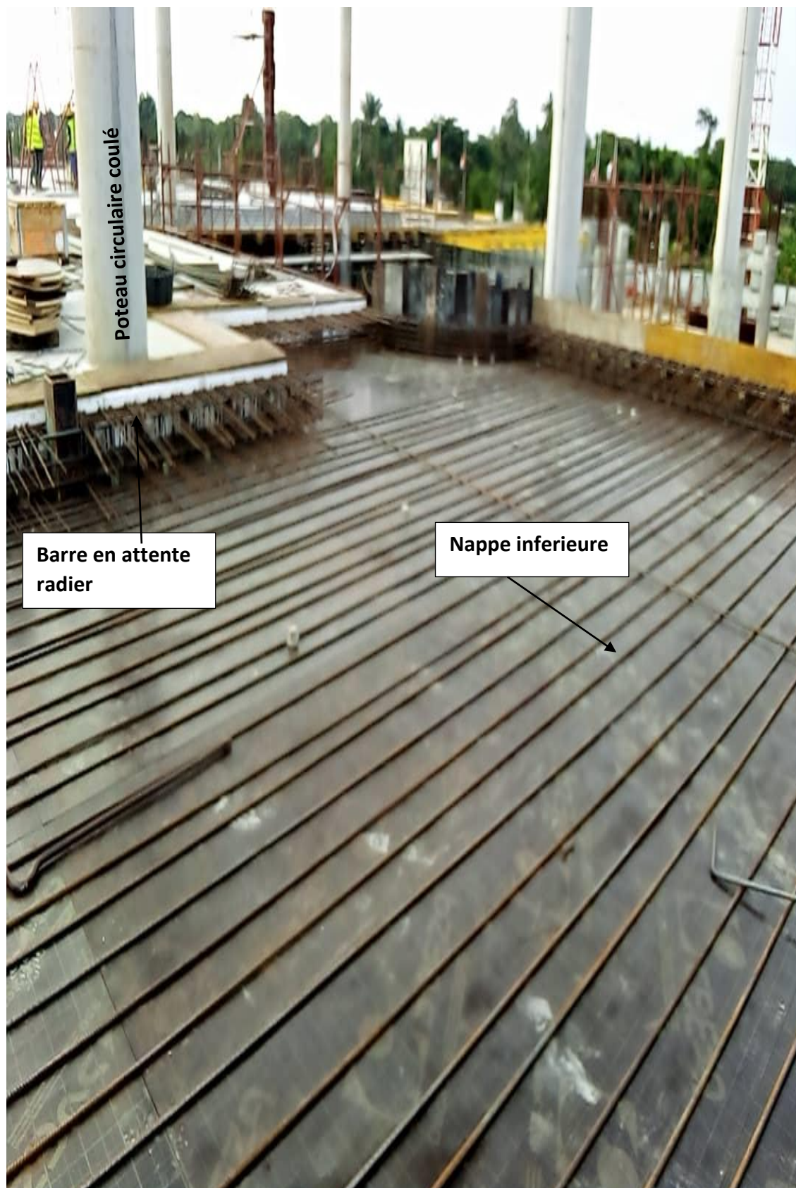
Plancher en cour de réalisation
