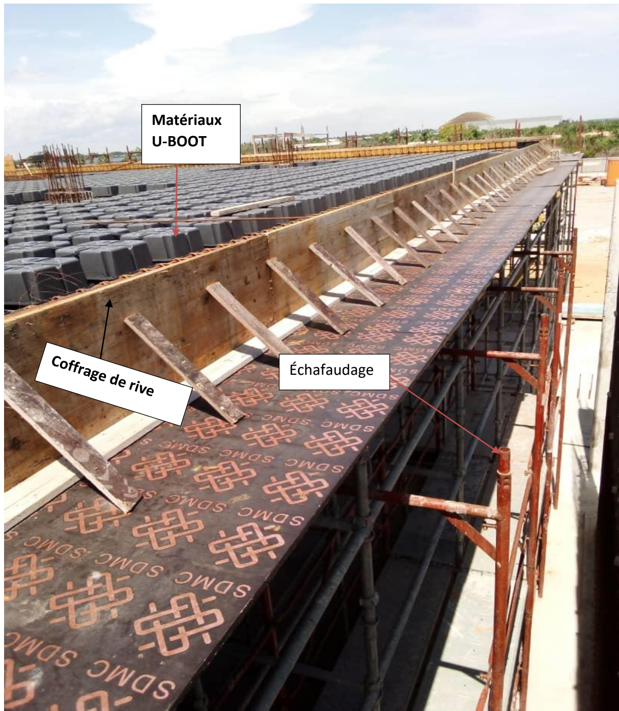
Coffrage de rive et disposition du matériau terminé
