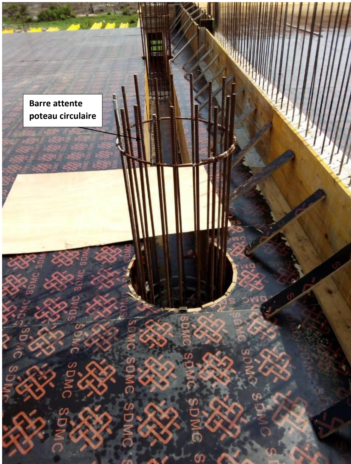
Vue du dessus de poteau circulaire
