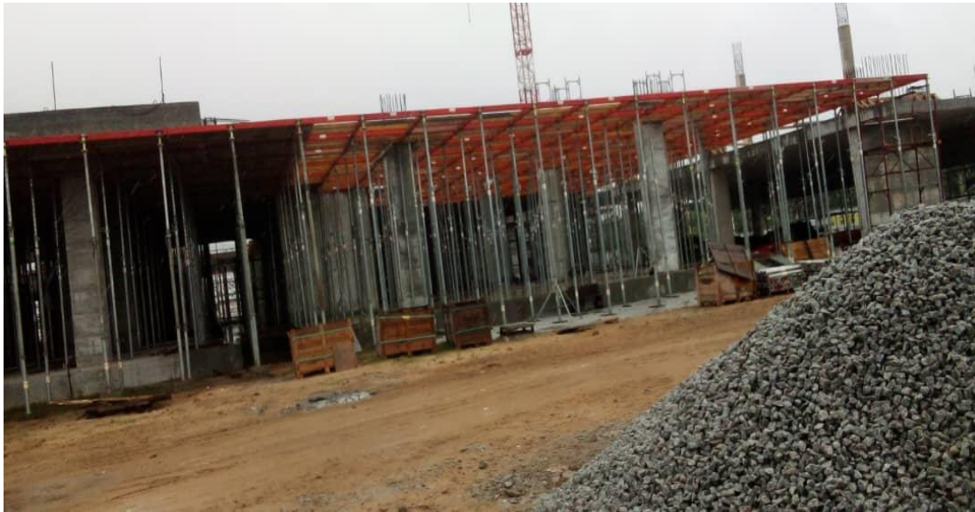
Vue de face le coffrage de dalle
