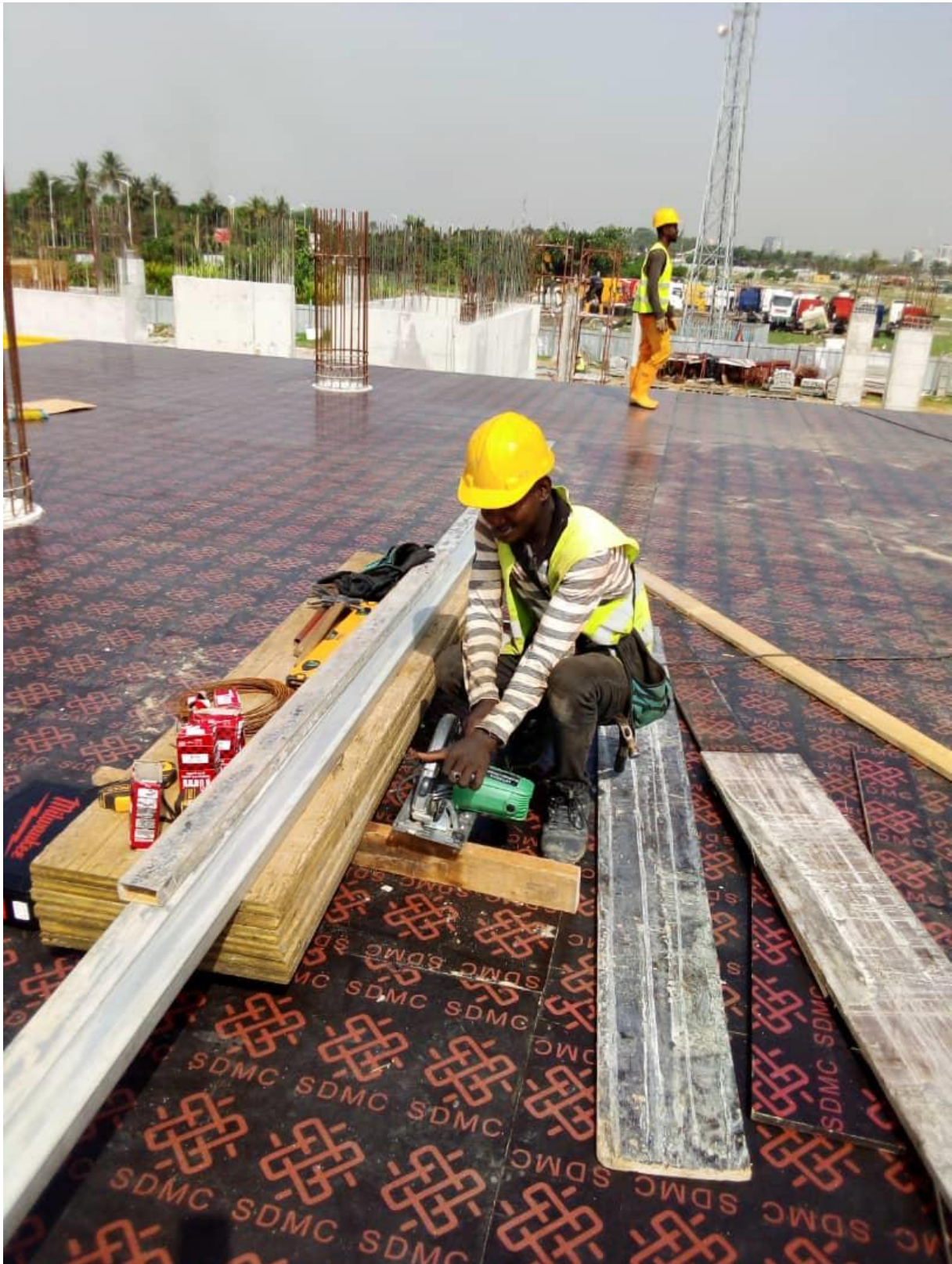
Séance de coffrage dalle
