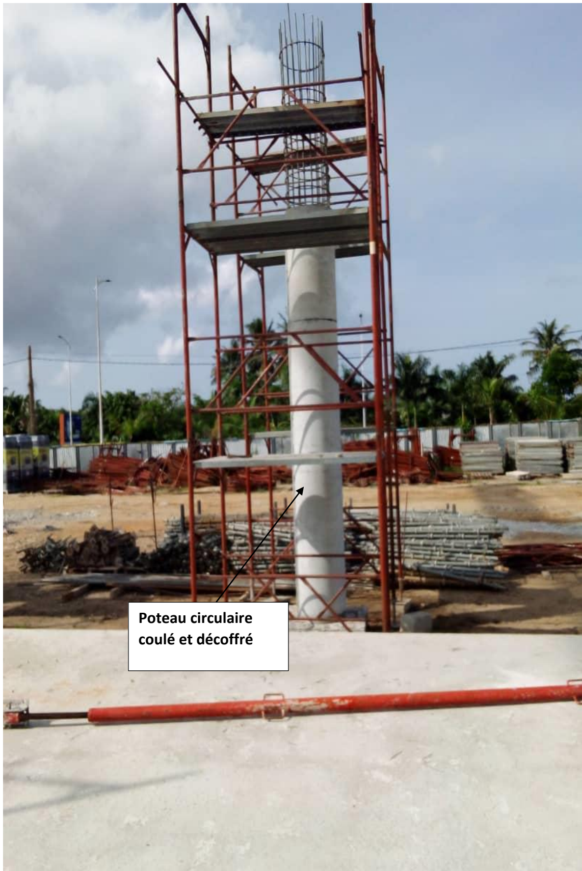
Elévation poteau circulaire
