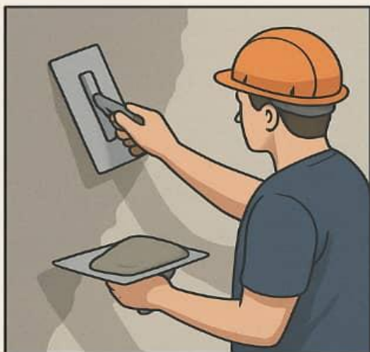
APPLICATION DE LA DEUXIÈME COUCHE
