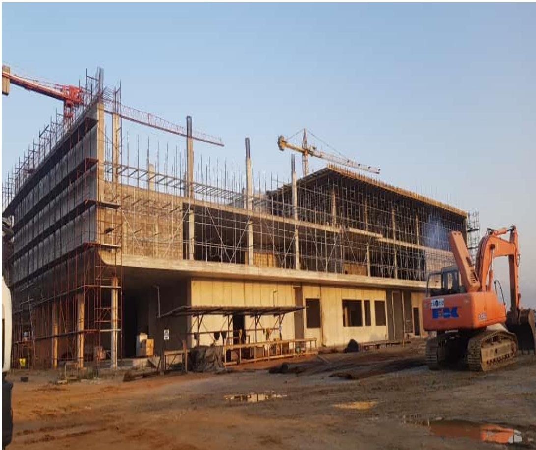
Vue de face le coffrage de dalle
