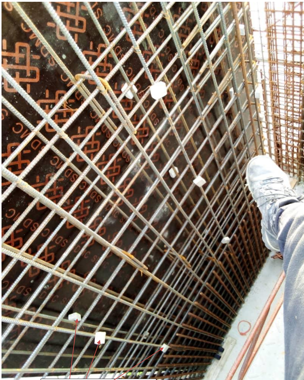
Cale a béton attaché sur le fer
