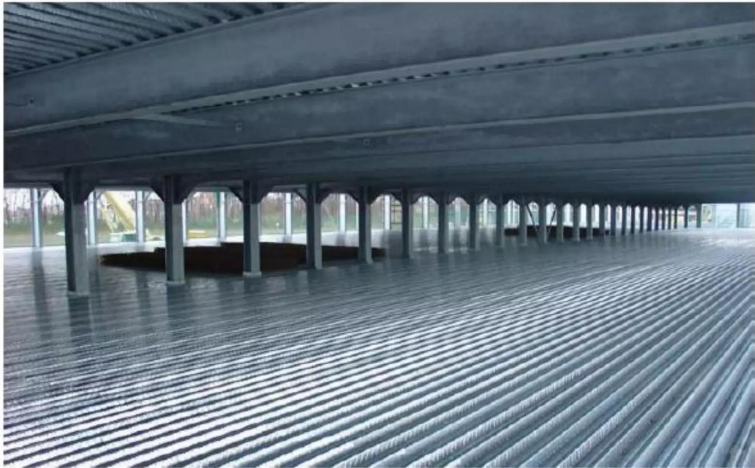
Figure1-8 : Exemple de construction avec dalle mixte non étayée.
