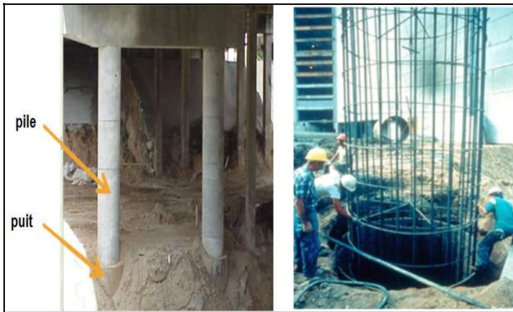
Figure I.11 : Exemple de réalisation des fondations semi-profondes. [4]
