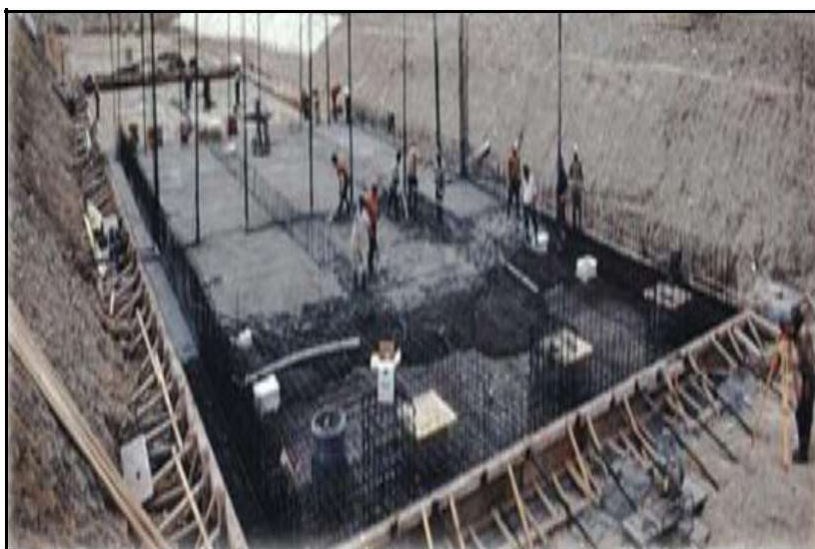
Figure I.10 : Exemple de réalisation d'un radier. [3]
