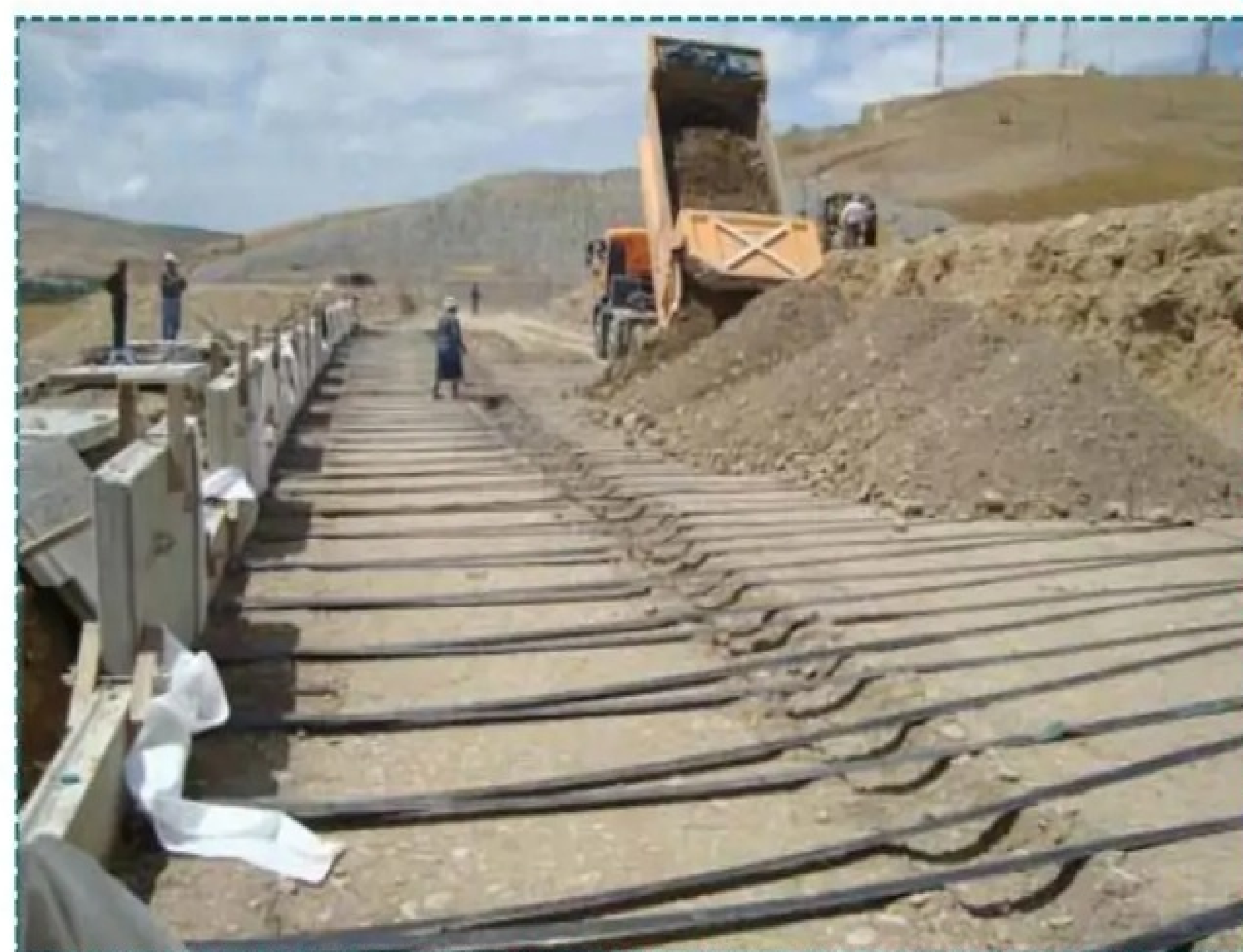
Fig 2 : Massif en terre armée
