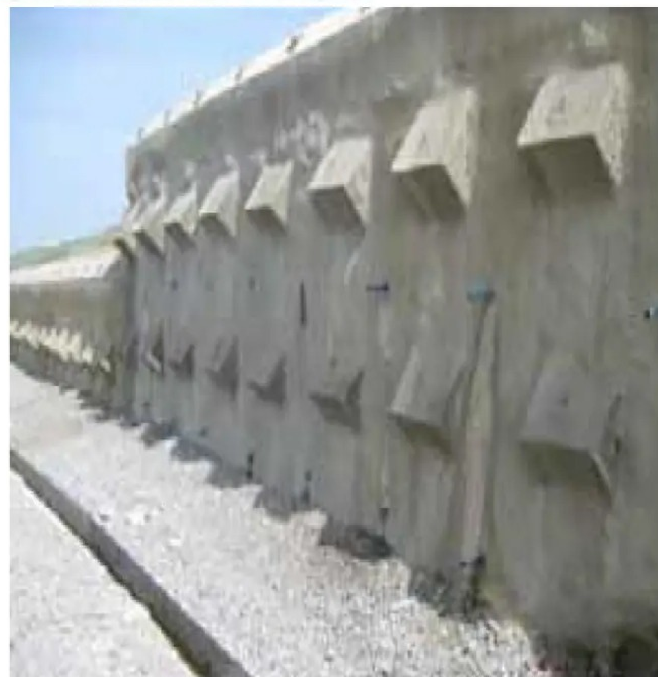
LIGNE FERROVIAIRE TANGER/RAS RMEL - CONFORTEMENT PK35 PAR PIERRE ++ TROIS LIGNES DE TIRANTS
