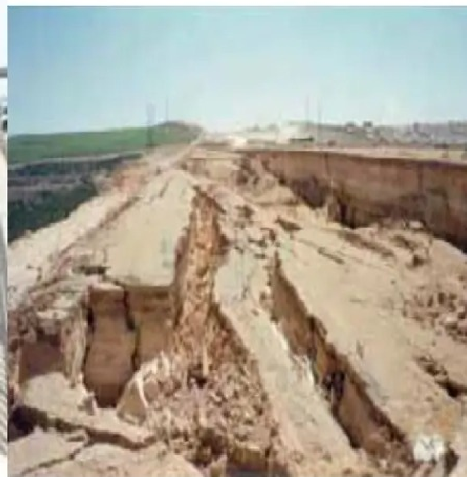
Autoroute Rabat/Fes - RM stabilisé par une butée (remblai sur versant)
