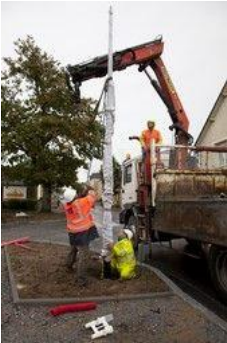
Travaux d'éclairage public
