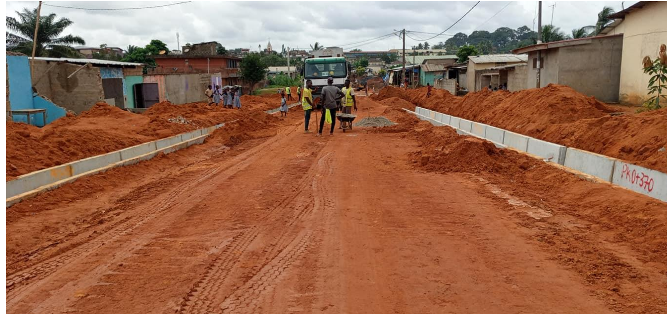
Travaux de terrassement
