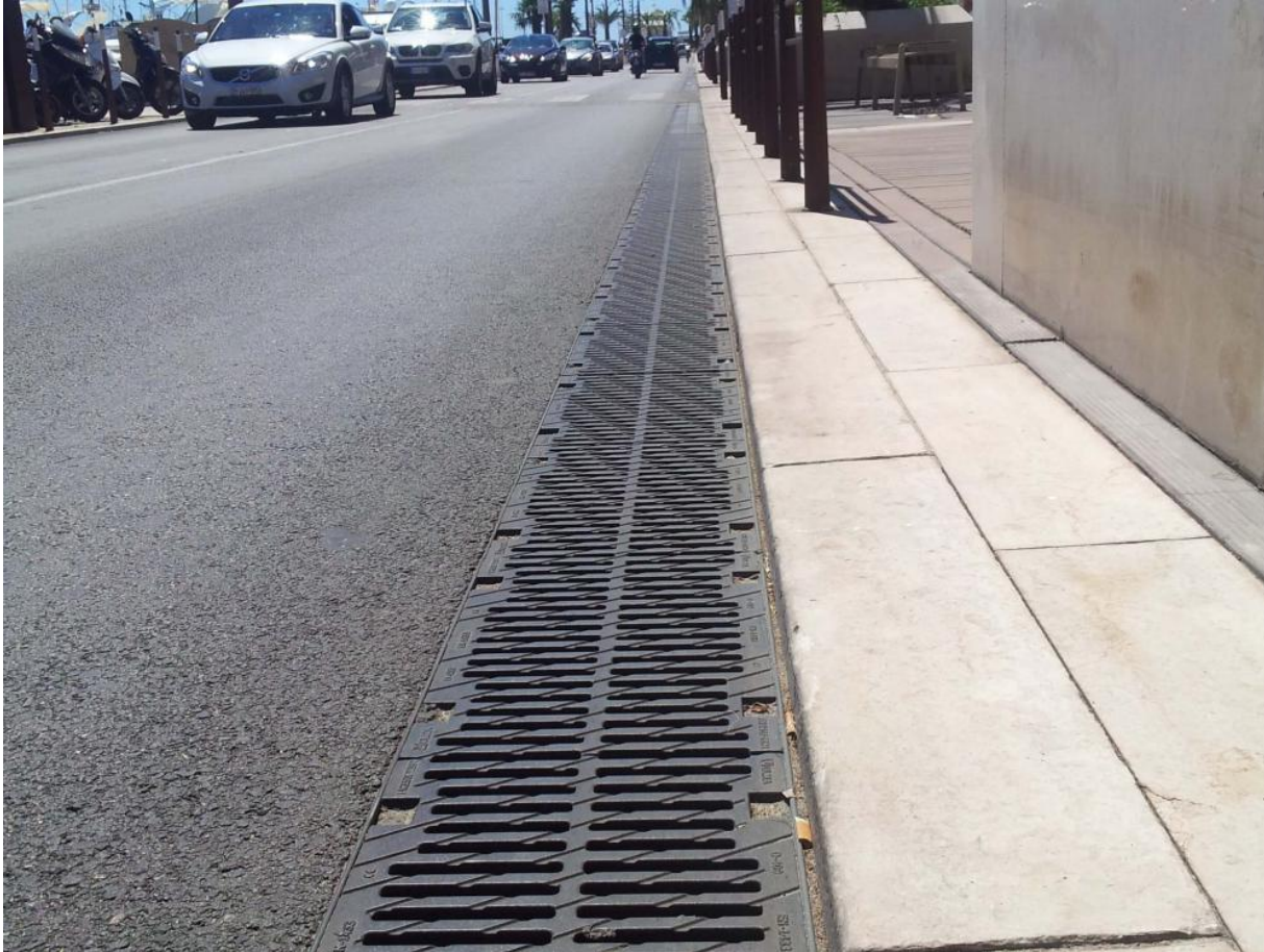
Pose des caniveaux
