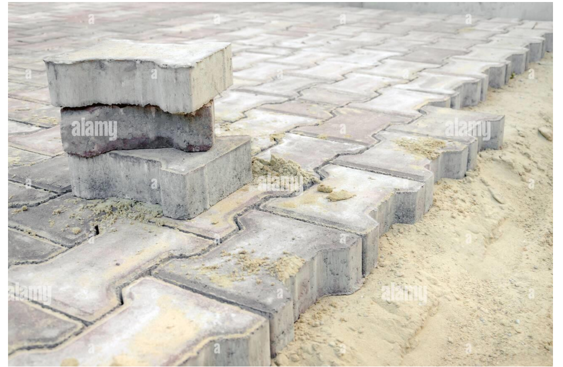
Travaux de revêtement des trottoirs
