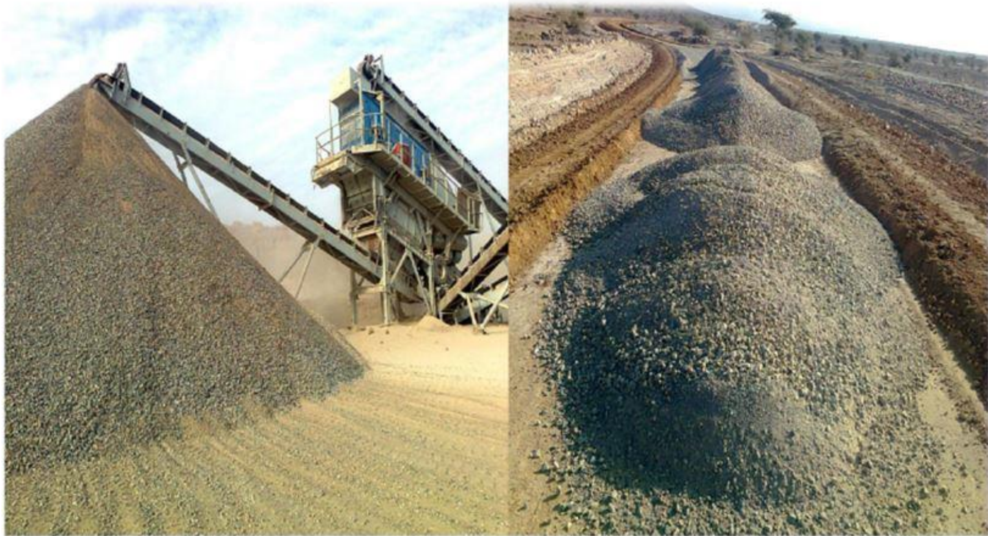
Production des matériaux GNF - GNB www.cours-genie-civil.com
