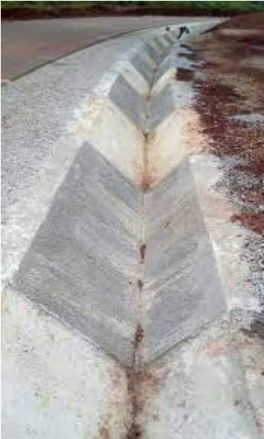
Fossé triangulaire en béton
