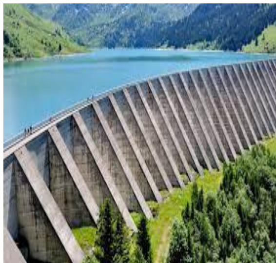
Figure 7 : Barrage à contreforts (Schleiss and Pougatsch, 2011)
