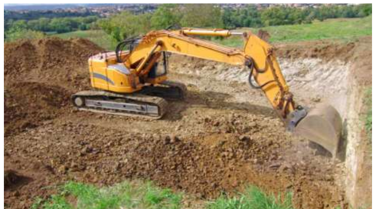
Figure 1: Terrassement d'un terrain
