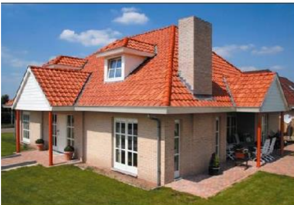
Toit en tuiles
