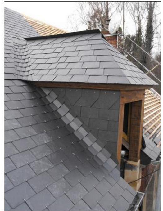
Toit en ardoises
