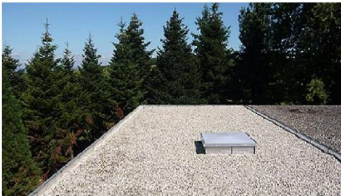
Protection lourde ( gravillon ) - terrasse inaccessible
