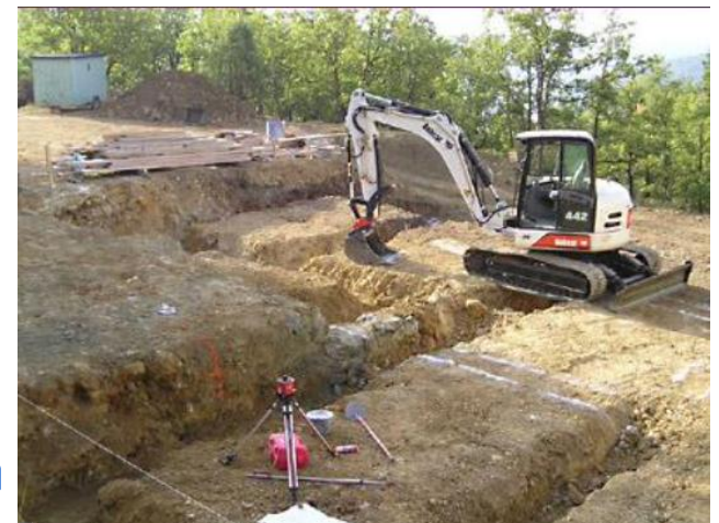
Terrassement : Grande masse avec talutage
