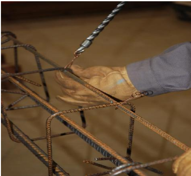
Assemblage par lieur automatique
