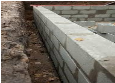
Mur de soubassement en agglos
