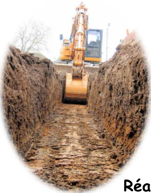
Décapage - Fouille en pleine masse
