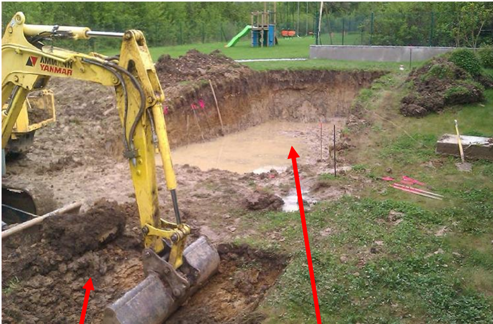
Décapage - Fouille en pleine masse
