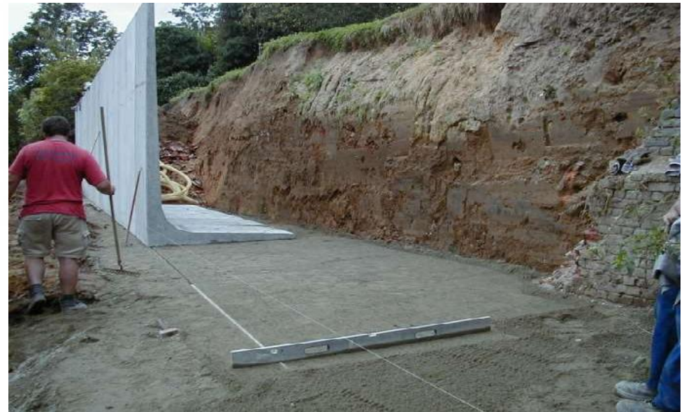
Mur de soutènement en BA
