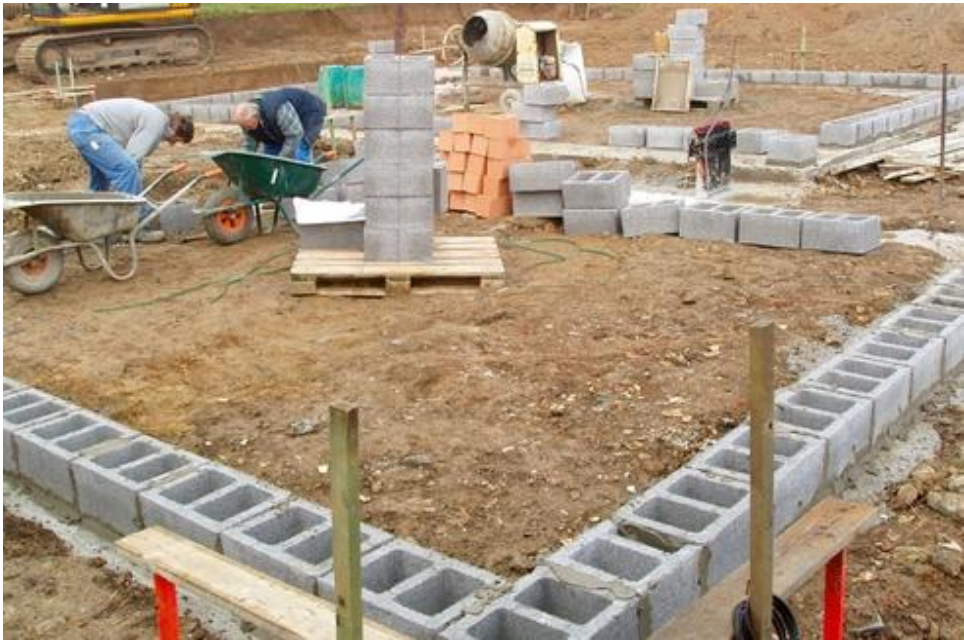
Semelle continue en maçonnerie
