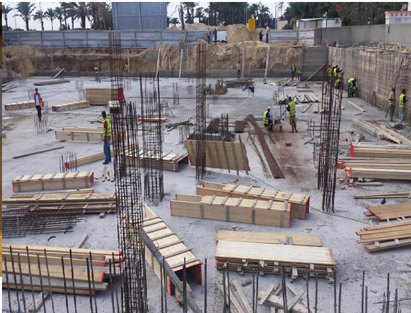
Mise en place
