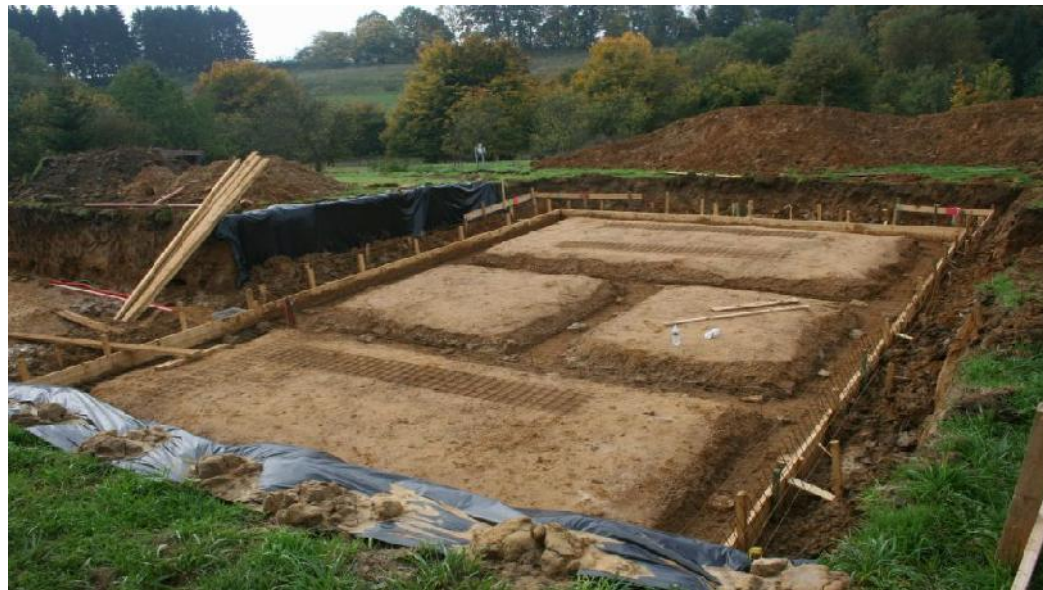
Réalisation fouille en tranchée
