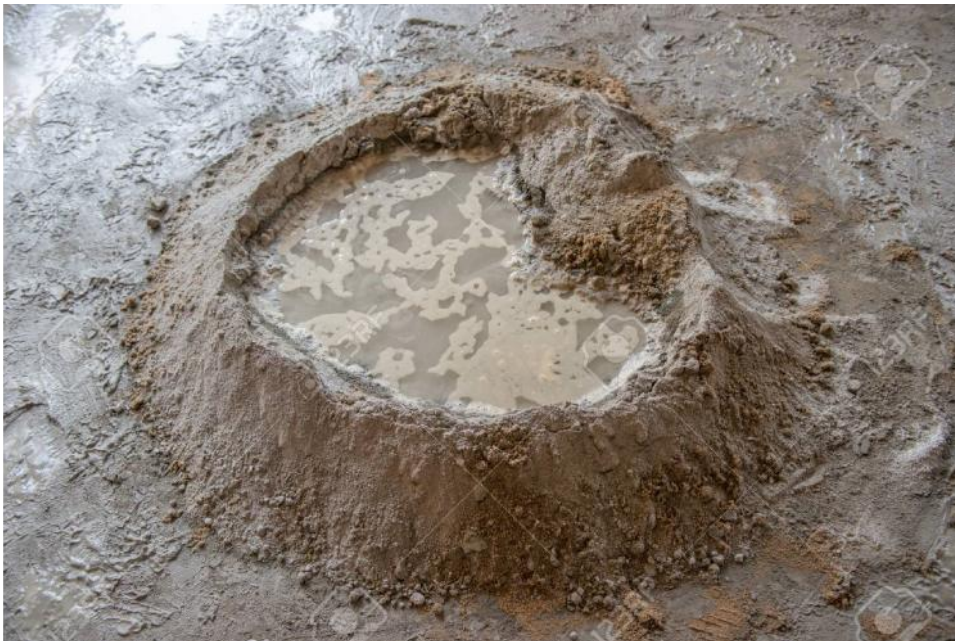
Verser l'eau nécessaire
