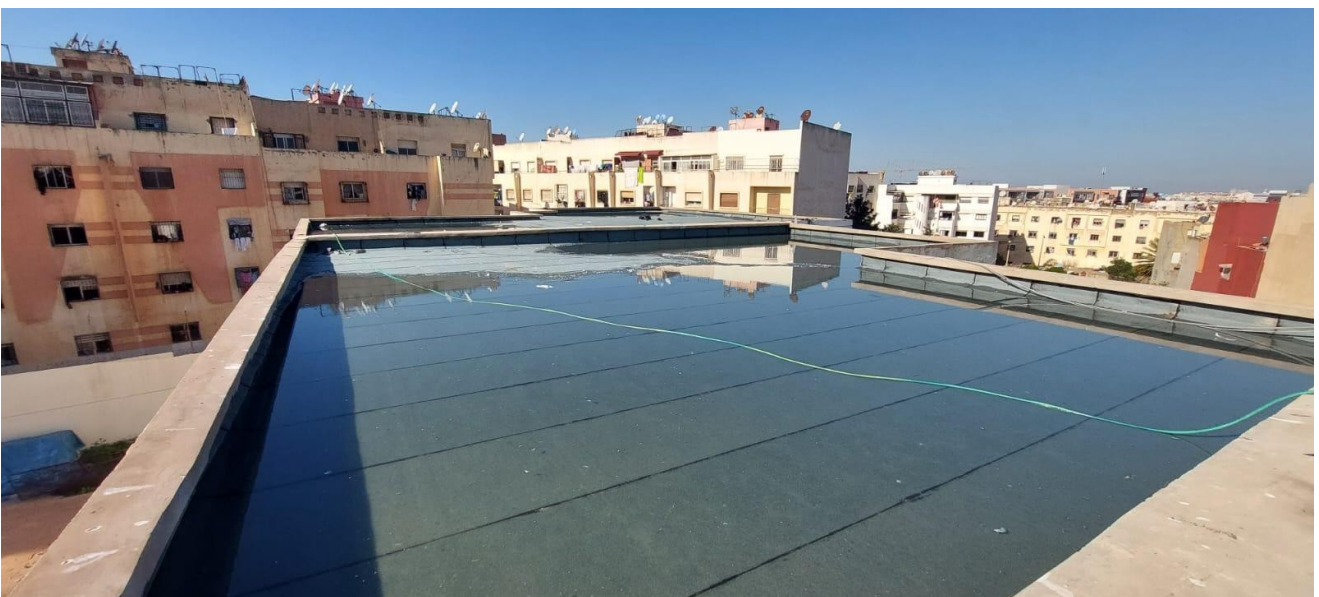
Figure 54: Essai de mise en eau
