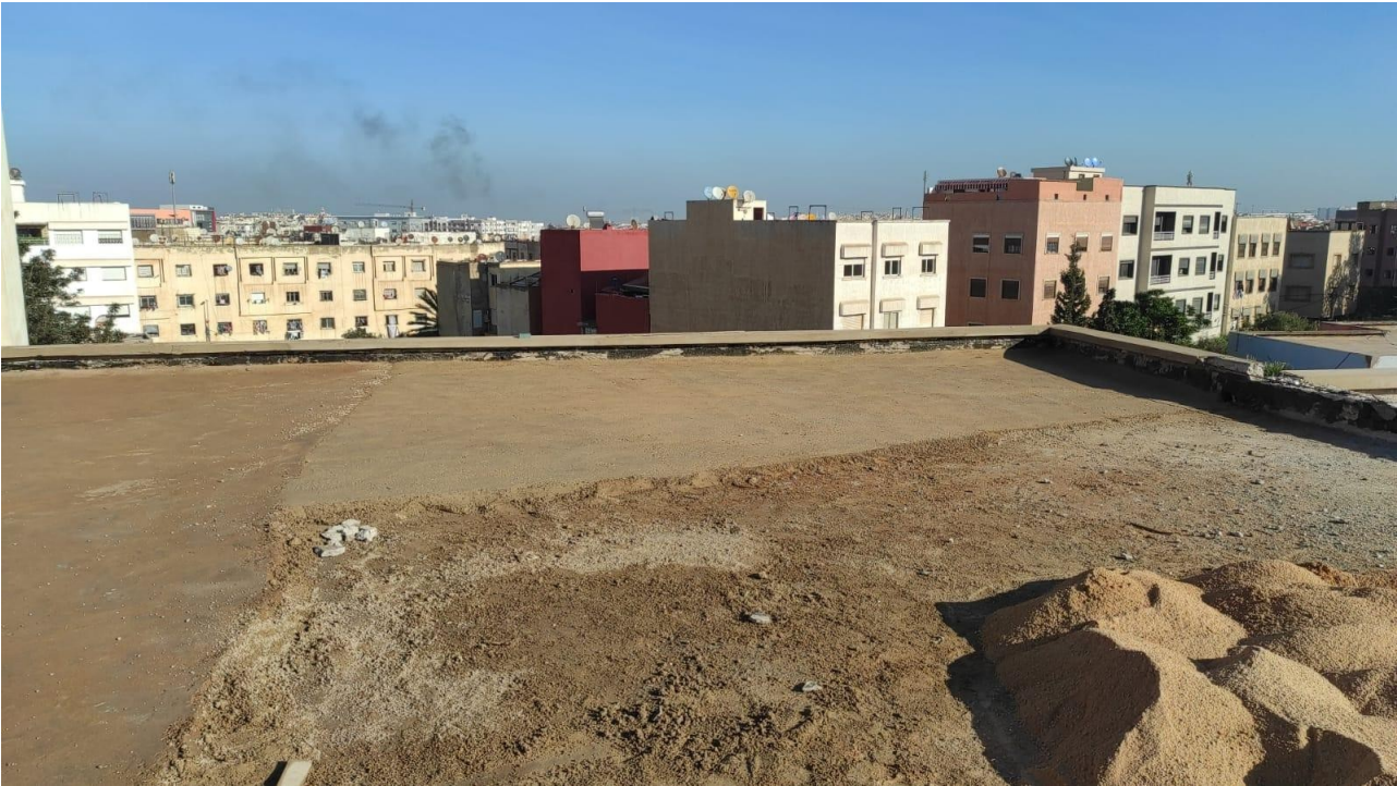
Figure 53: la reprise de la forme de pente et la réfection du couronnement d'acrotère
