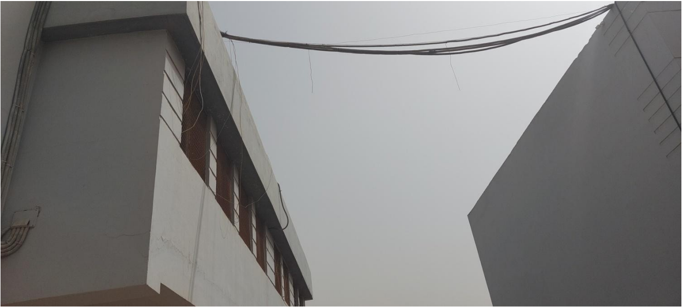
Figure 51: L'état des lieux avant de commencer les travaux
