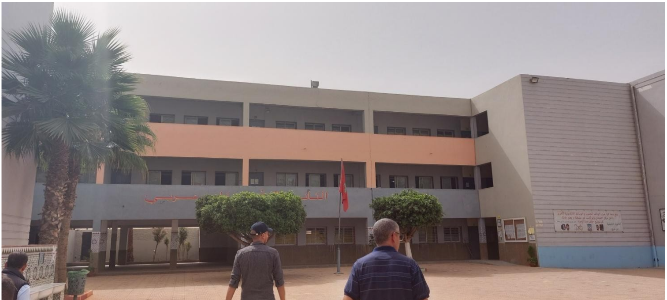
Figure 50: Première visite avant le commencement des travaux
