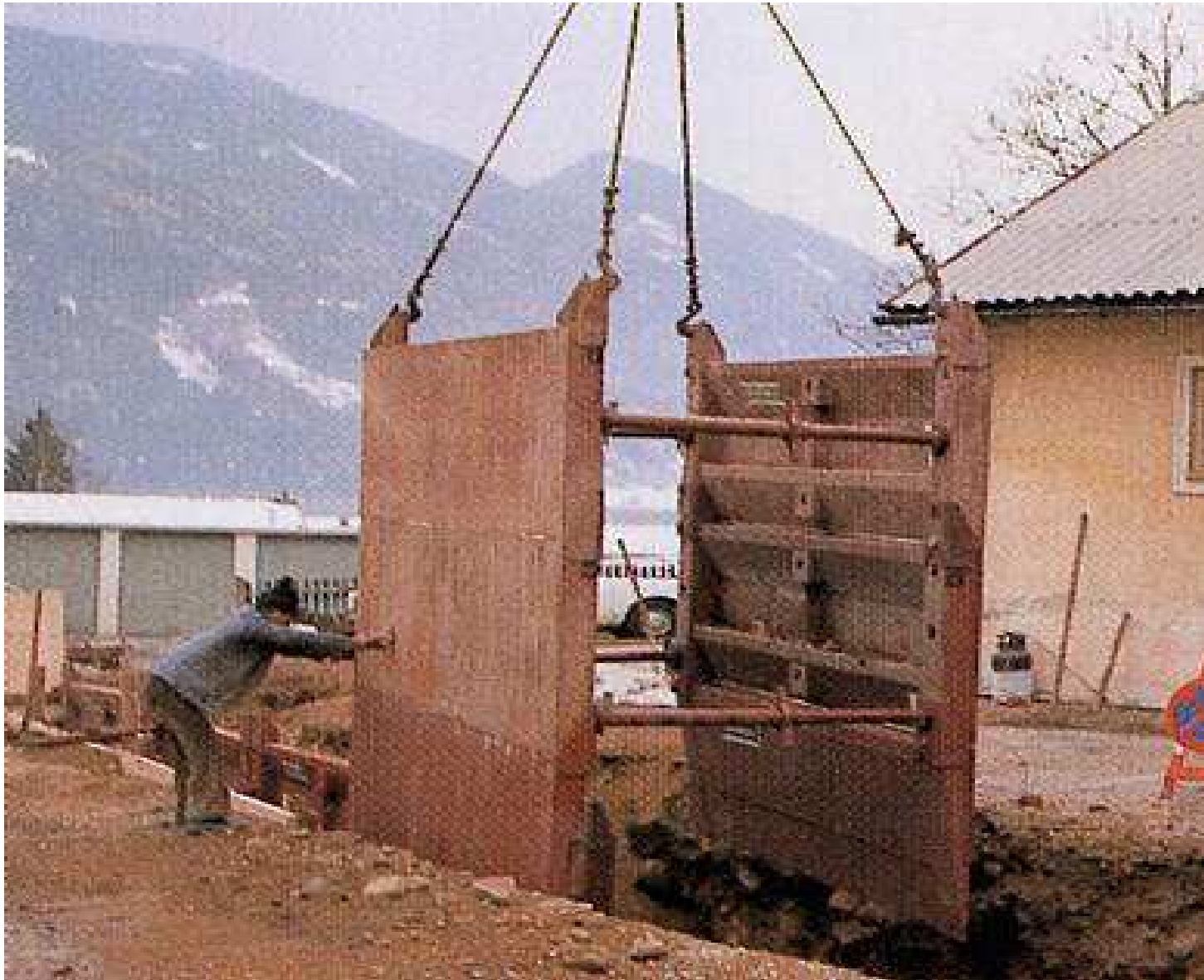
Introduction du caisson au sein de la fouille
