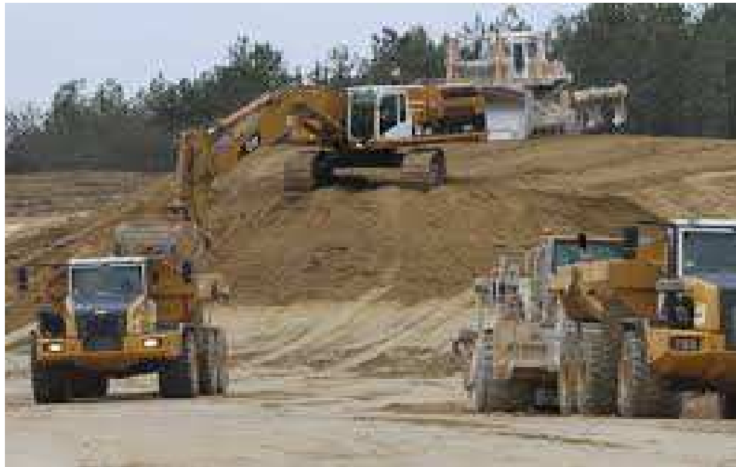
Chantier de terrassement autoroutier
