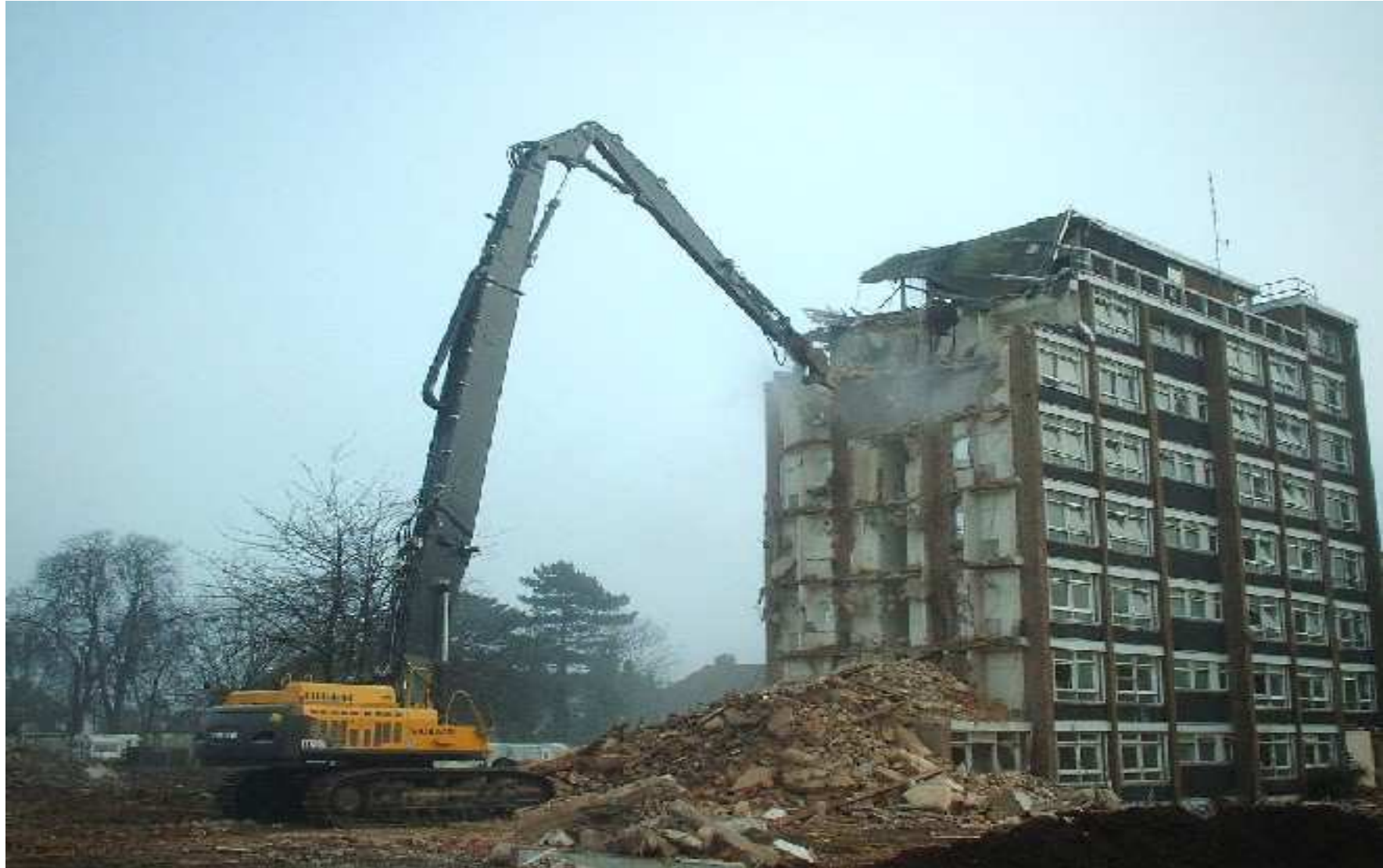
Pelle équipée d'outils de démolition
